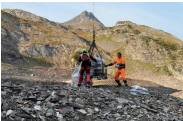
TUTTO IL MATERIALE NECESSARIO È STATO TRASPORTATO SUL LUOGO DELL'INTERVENTO IN UN UNICO VIAGGIO IN ELICOTTERO
